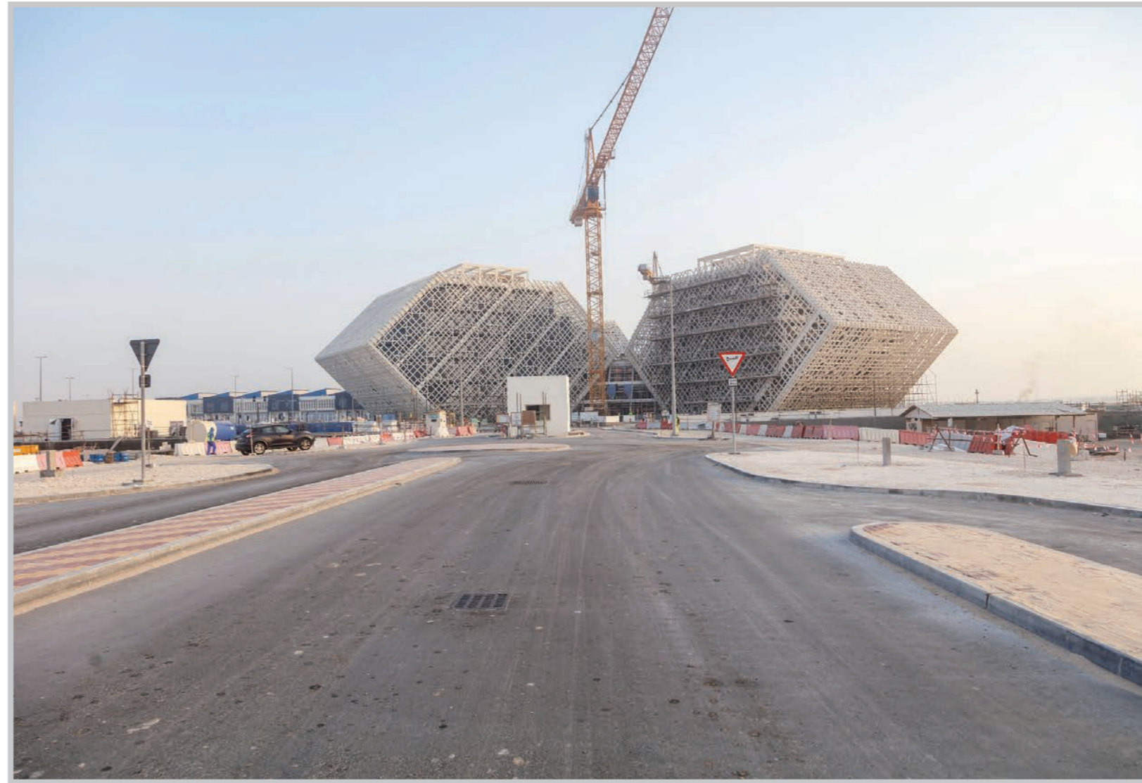
مبنى مجمع الابتكار والأعمال - المنطقة الحرة
