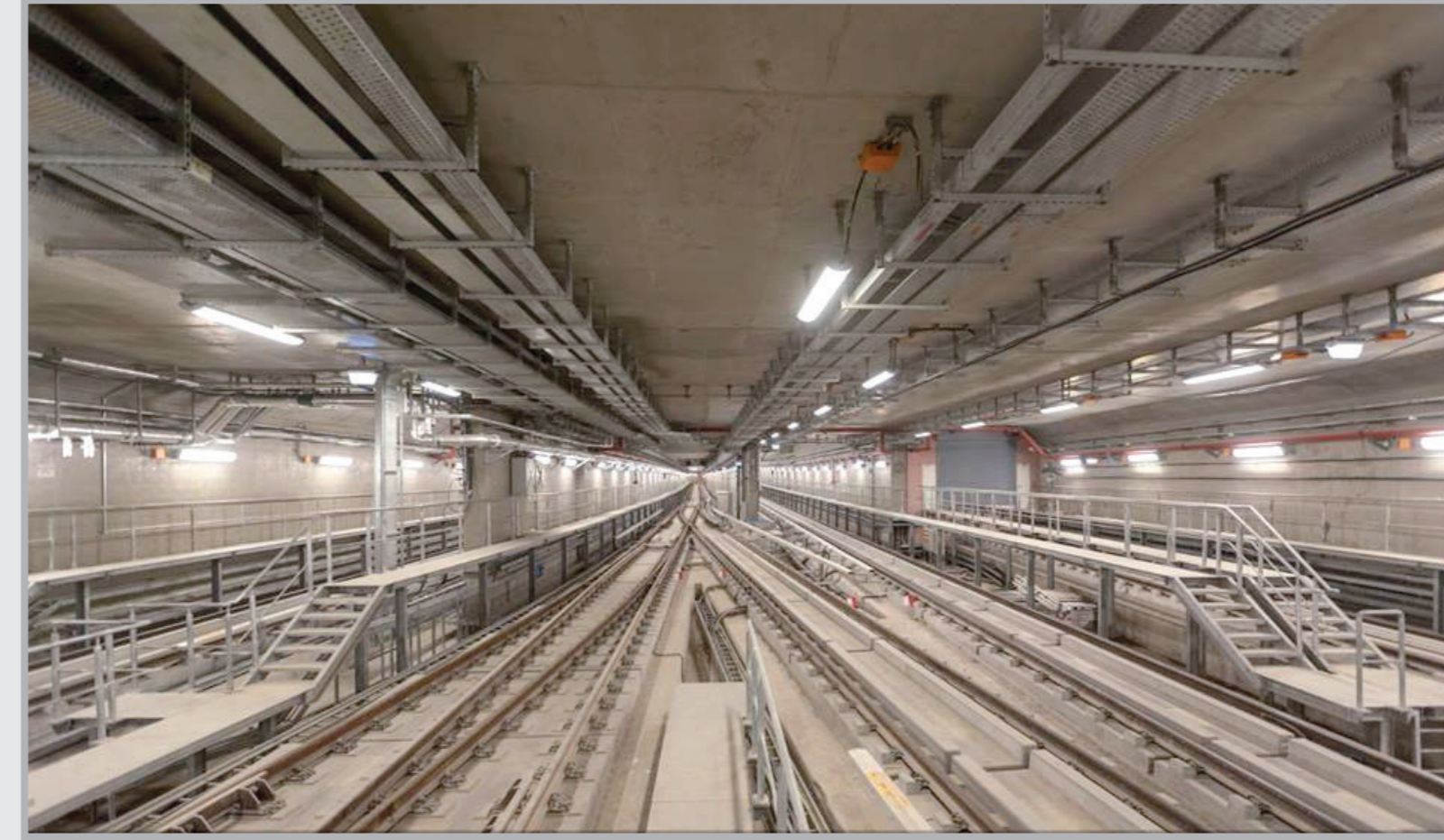
منطقة تبديل المسارات المؤدية لمحطة مطار حمد الدولي ومحطة الوكرة بالخط الأحمر
