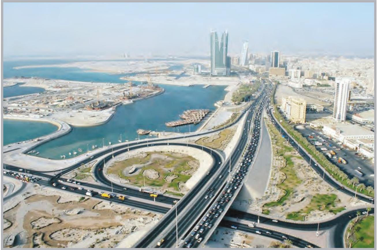
■ سلطنة عمان تتوسع في شبكات الطرق لتسهيل النقل التجاري
